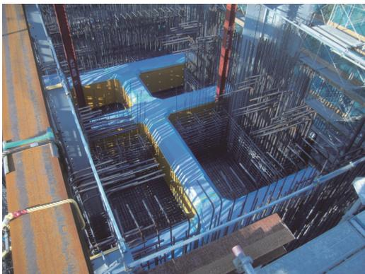
写真 - 5 柱頭部人通孔の施工状況
