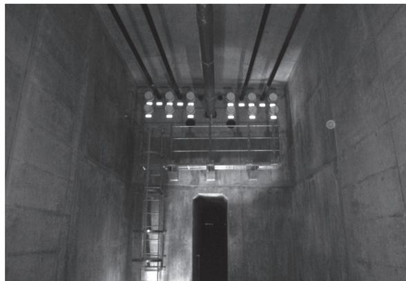
写真-10 PC箱桁内の点検施設
