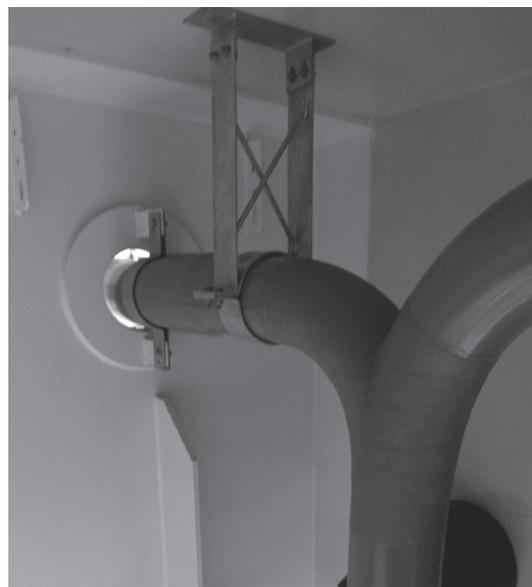
写真-12 排水管のFRP補強
