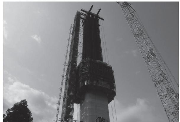
写真 - 9 鋼管・コンクリート複合構造橋脚
