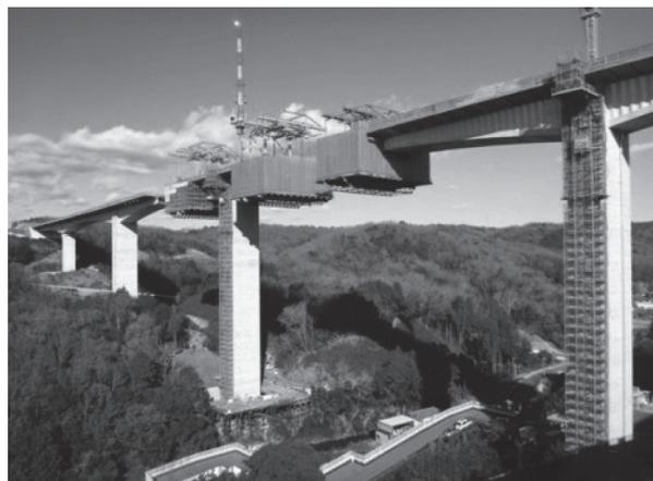
写真-7 移動作業車による施工状況(上下一体構造)
