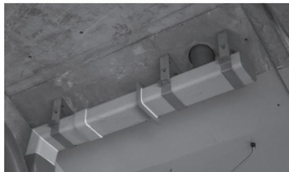
写真-11 排水管の水切板
