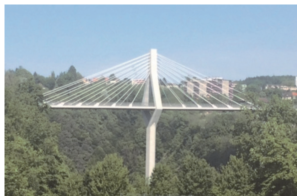
写真 - 6 Poya Bridge
