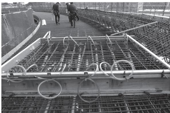
写真 - 9 緊張端ブロックのケーブルシースと鉄筋
