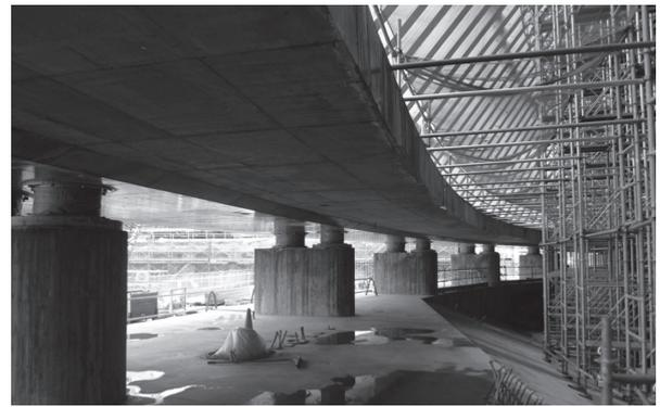
写真 - 7 柱頭の免震装置
