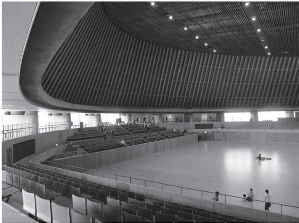
写真 - 6 防炎装置としての RC 水平リング
