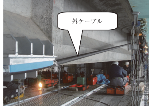
写真 - 5 外ケーブル緊張状況
