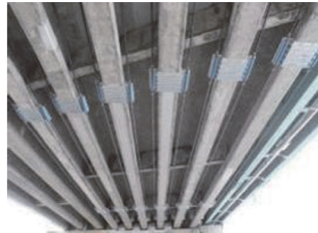
写真 - 6 緊張完了後全景
