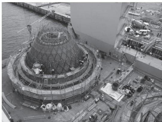
写真 - 5 基礎の製作状況 FD 上（コンクリート打設状況）
