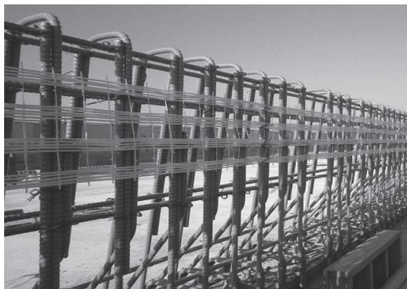
写真 - 10 耐アルカリ性ガラス繊維材の設置状況
