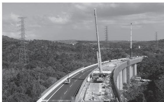
写真 - 4 伊芸高架橋（上り線）の床版取替え状況
