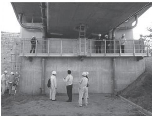
写真 - 2 橋梁用の FRP 製点検路
