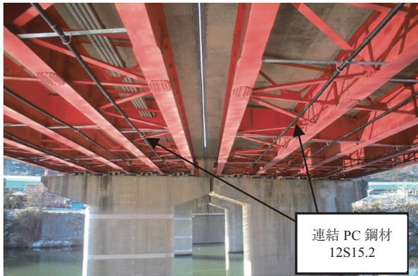
写真 - 1 連結 PC 鋼材配置
