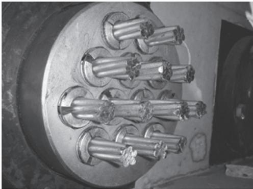
写真 - 10 PC 鋼材および定着具の現況
