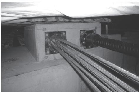
写真 - 4 PC 鋼材の挿入
