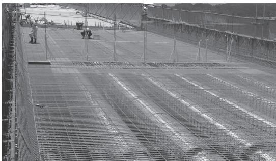
写真 - 8 床版上面へのエポキシ鉄筋の使用
