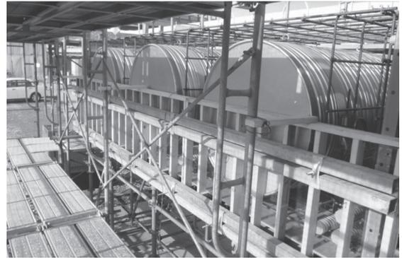
写真 - 1 型枠組立完了
