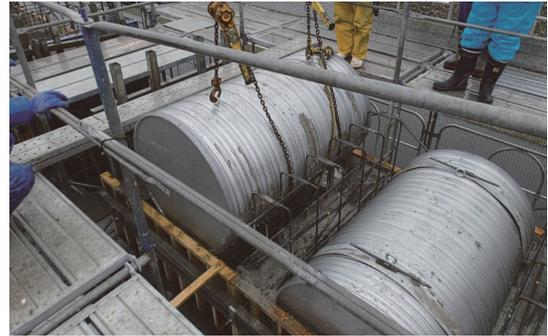
写真 - 6 円筒型枠の取外し状況
