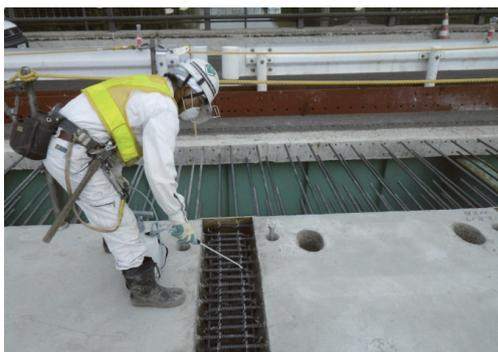
写真 - 4 けい酸塩系表面含浸材の噴霧状況
