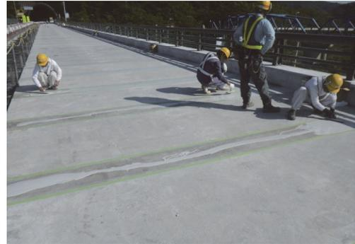
写真 - 5 水性エポキシ樹脂配合複合塗膜防水材料の塗布状況
