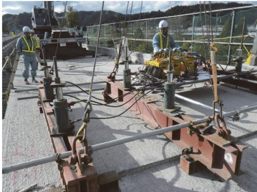
写真 - 1 既設床版引剥がし状況
