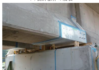
(f) 桁端の断面修復
