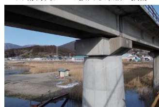
(g) RC 巻立て補強とストッパーの設置
