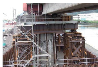
(d) 桁の仮受け
