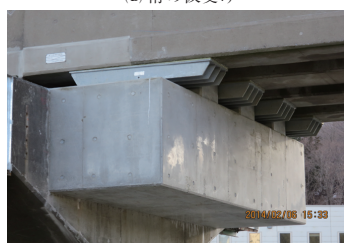
(g) ストッパーの新設
