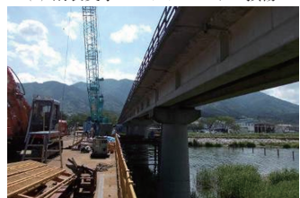
(f) 復旧工事の状況
