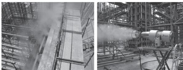
写真 - 1 ノズルパイプ 写真 - 2 バズーカノズル
