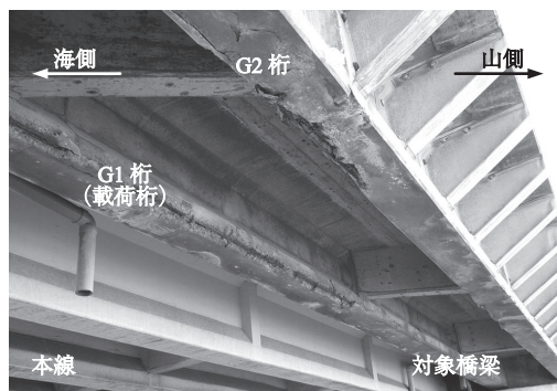
写真 - 1 撤去前の状況
