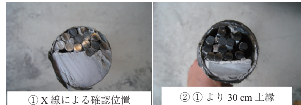
図 - 8 グラウト確認状況
