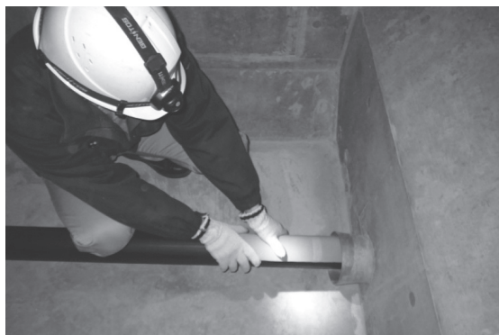
写真 - 4 ケーブル長測定
