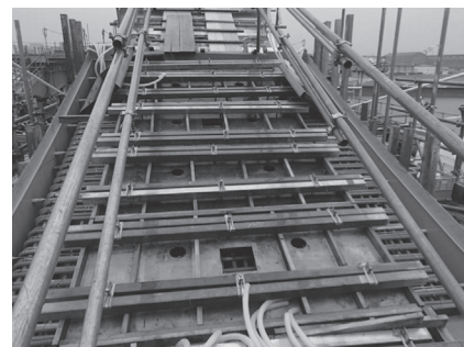
写真 - 7 フィンバック部の上面型枠
