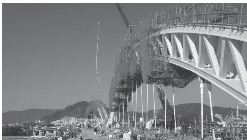
写真-17 吊ケーブル架設状況
