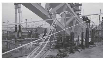
写真 - 14 仮斜材架設状況
