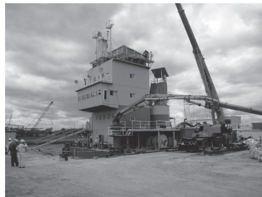
写真 - 3 CP 船による圧送試験
