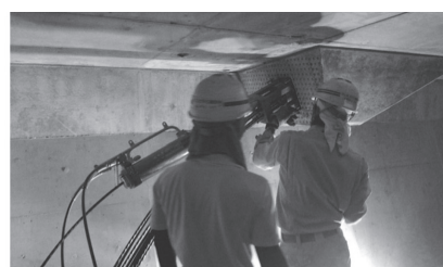
写真 - 15 仮斜材解放状況
