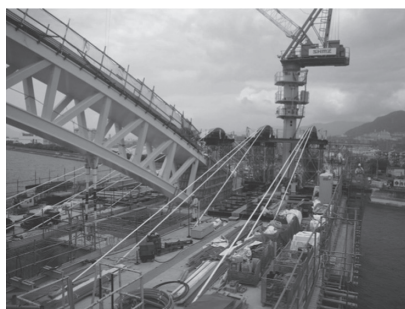
写真 - 10 仮斜材状況
