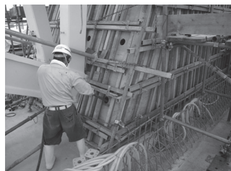
写真 - 8 フィンバック部の側面型枠
