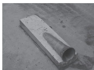
写真 - 13 主桁偏向部
