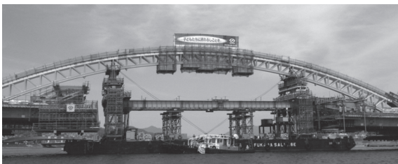
写真 - 6 アーチ架設状況
