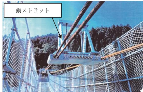
写真 - 10 吊床版鋼ストラット同時架設状況
