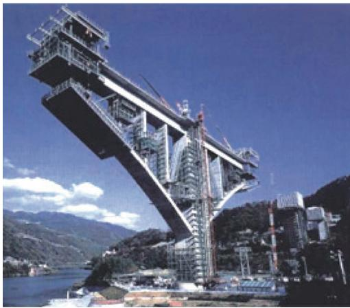
写真 - 2 トラス張出し架設
