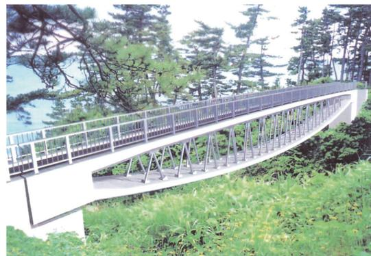
写真 - 11 自碇式吊床版橋
