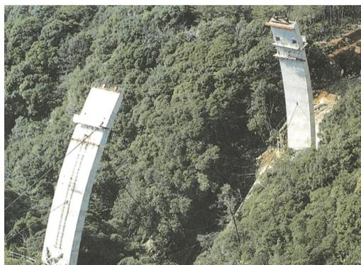
写真 - 4 ロアリング架設<sup>1)</sup>
