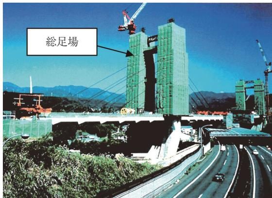
写真 - 5 主塔の架設 (総足場工法)<sup>1)</sup>
