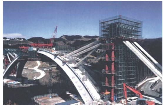
写真 - 3 斜吊り張出し架設<sup>1)</sup>
