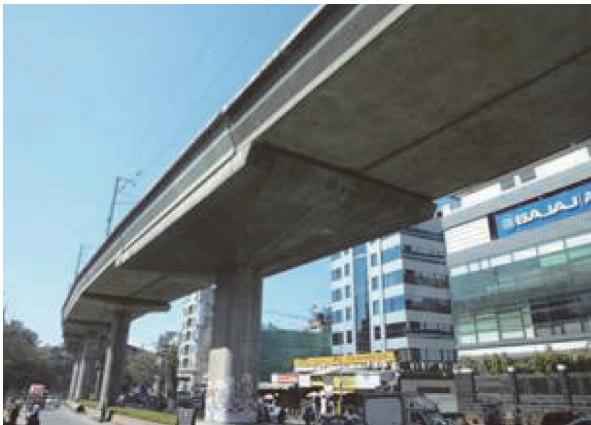
写真 - 5 Mumbai Metro Line 1 の高架構造
