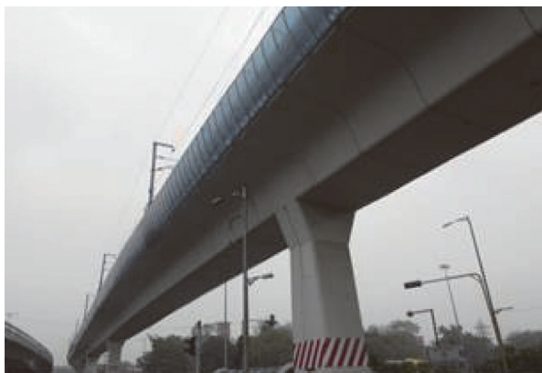
写真 - 12 Moolchand 駅付近に架かる高架橋
