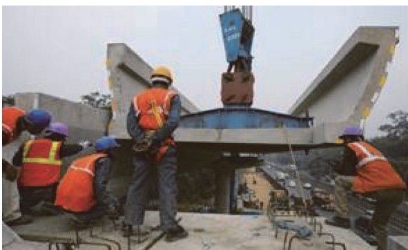
写真 - 6 U 型断面の PC 桁の架設 3)
