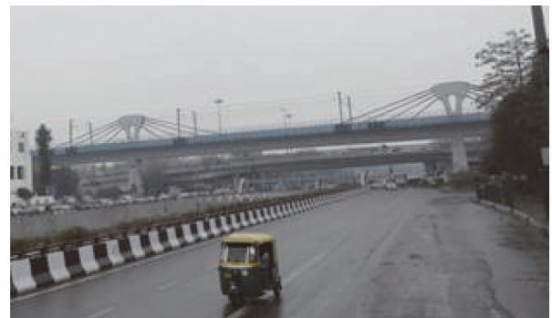
写真 - 11 Moolchand 駅付近に架かるエクストラード橋
