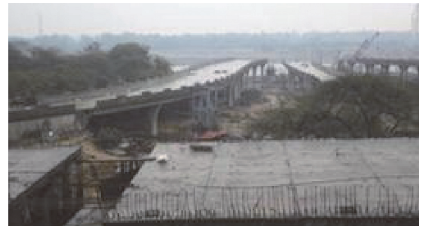
写真 - 7 45 号線から臨む西側アプローチ
