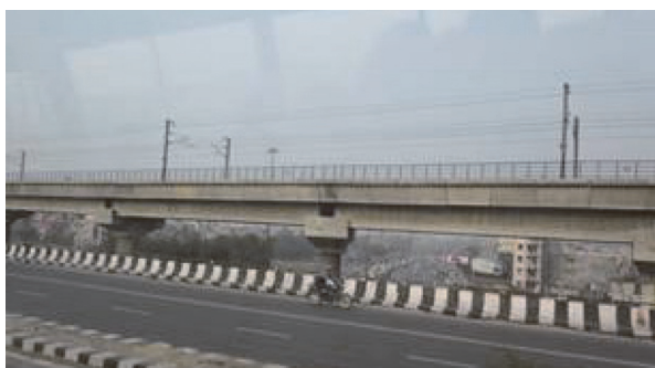
写真 - 13 Mavur vihar Extn 駅付近に架かる高架橋
