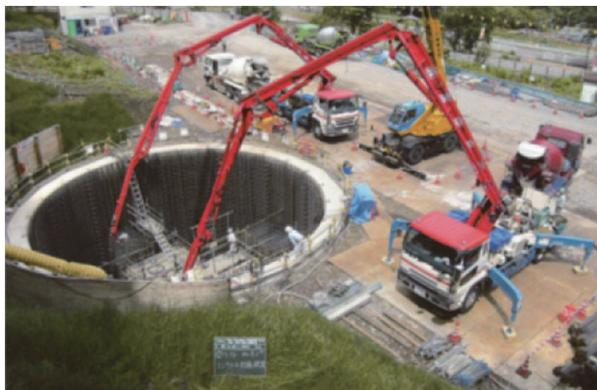
写真-4 湖面1号橋の大口径深礎杭
