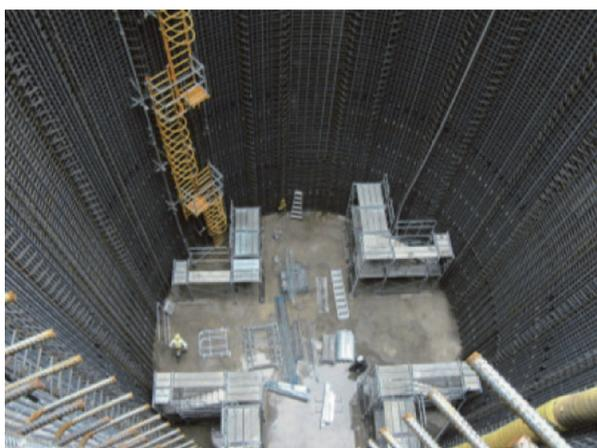
写真-5 湖面1号橋の大口径深礎杭の配筋
