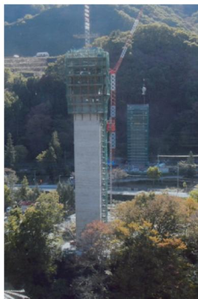
写真-6 湖面1号橋の昇降式移動足場（手前P3橋脚）と枠組足場（後方P4橋脚）
