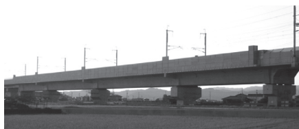
写真 橋 梁 全 景
