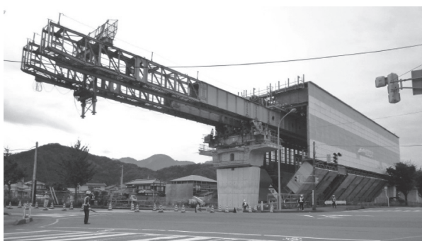
写真-2 移動支保工
