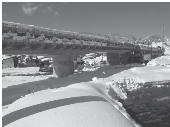
写真 - 2 冬季の綱切線架道橋
