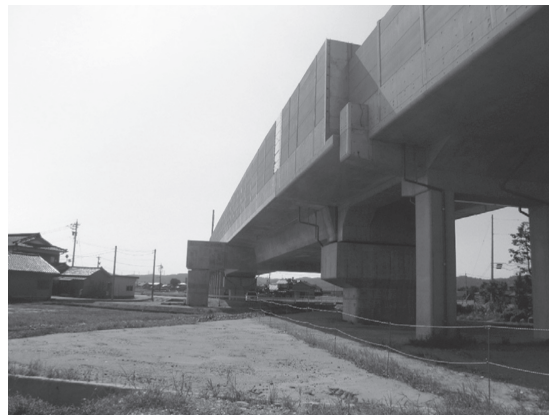
写真 坂又川橋梁
