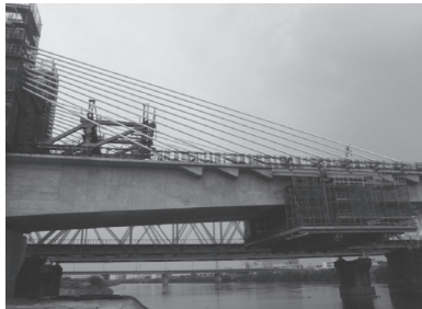
写真 - 2 移動式作業車の分離解体
