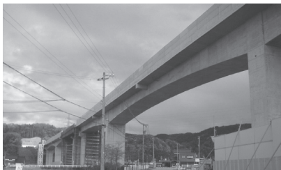
写真 - 2 富川橋梁（奥）と観音堂架道橋（手前）
