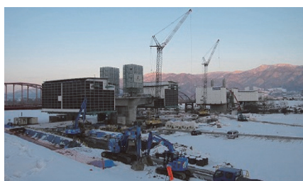
厳冬期に建設が進む中央橋（国道 403 号）
