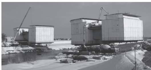
写真 冬期養生による張出し架設
