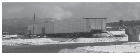
写真 - 3 養生仮囲い
