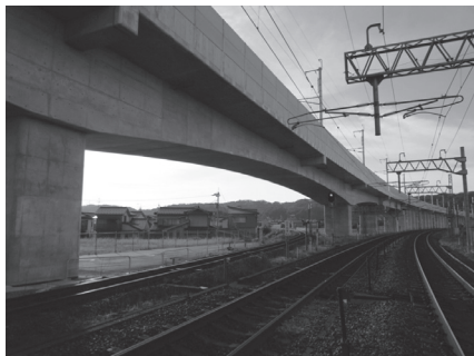
写真 西田刈屋線路橋（富山側から金沢側を望む）
