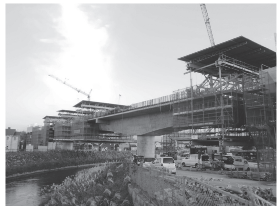
写真 張出し架設状況
