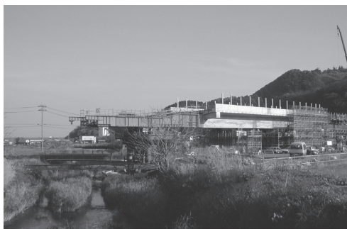
写真 押出し施工状況
