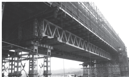
写真 大型トラス式支保工
