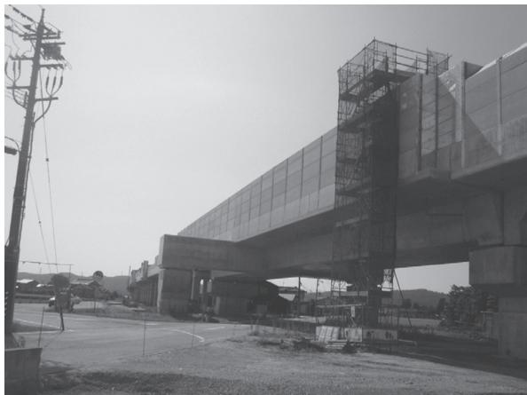
写真 東小神架道橋
