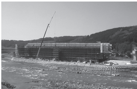
写真 上部工施工状況（3 渇水期目）
