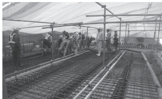
写真 - 4 床版・横桁コンクリート打設
