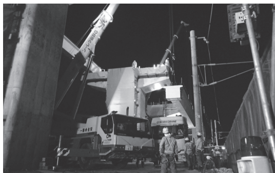
写真 - 3 主桁の架設
