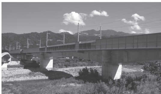
写真 橋梁全景
