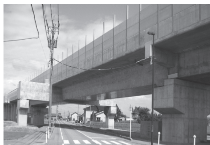
写真 第 1 安吉架道橋
