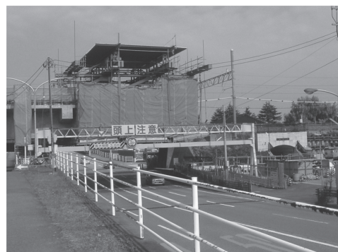
写真 超低床型ワーゲンによる張出し施工
