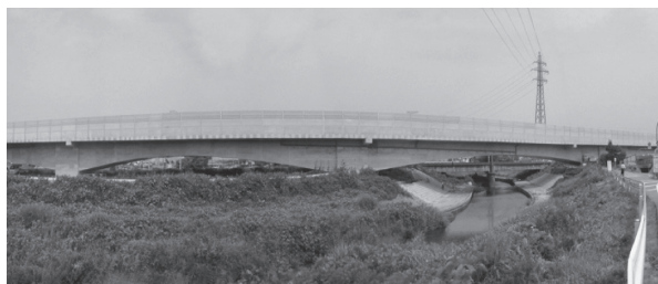
写真 金腐川橋梁全景
