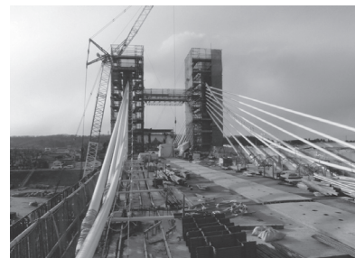
写真 - 3 斜材保護管吊上げ状況
