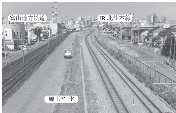
写真 - 1 架設地点（着手前）
