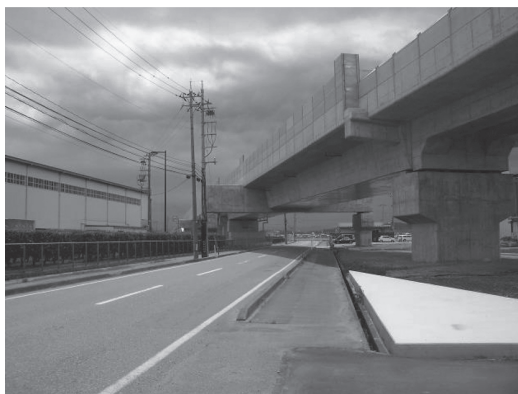
写真 - 1 鷲塚架道橋
