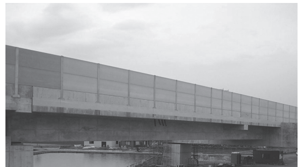
写真 完成時の全景
