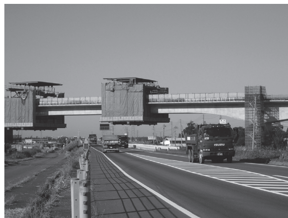
写真 張出し施工状況
