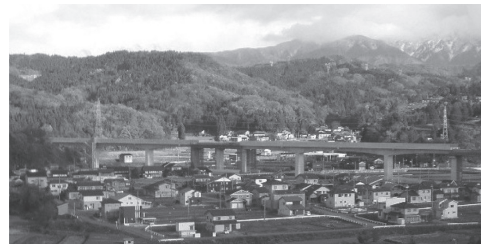
写真 - 1 富川橋梁（左）と観音堂架道橋（右）
