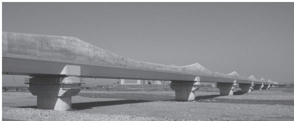
写真 - 1 姫川橋梁
