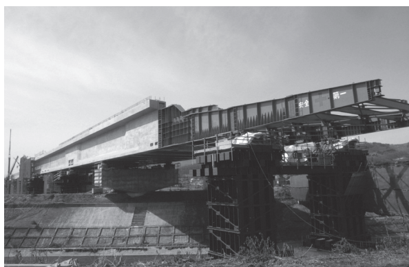
写真 - 1 押出し架設状況
