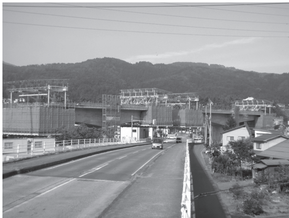
写真 - 1 新町架道橋 架設状況
