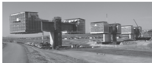
写真 上部工の張出し架設状況
