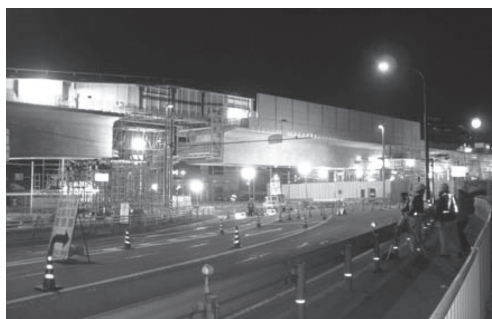
写真 - 1 橋桁押出し架設状況
