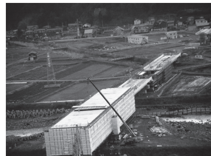
写真 早川橋梁施工状況
