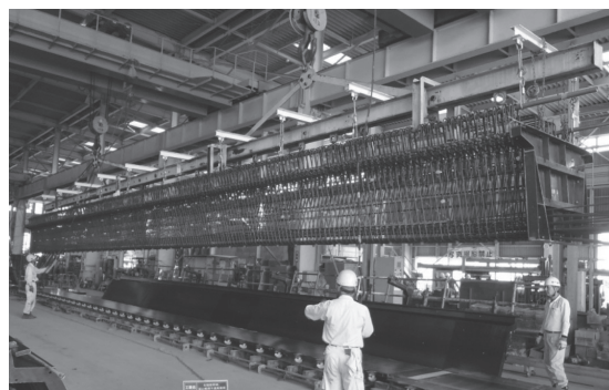
写真 - 2 地組鉄筋設置
