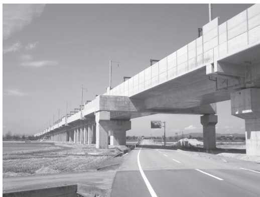
写真 戸破架道橋
