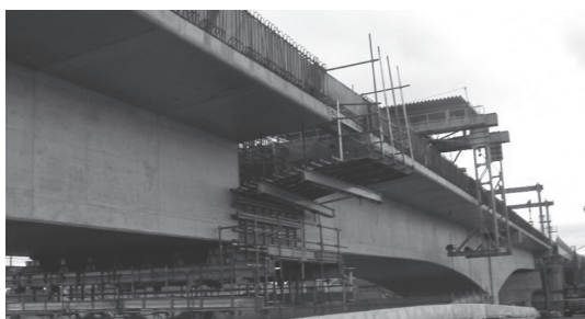
写真 中央径間連結部吊支保工
