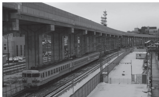
写真 - 5 施工完了
