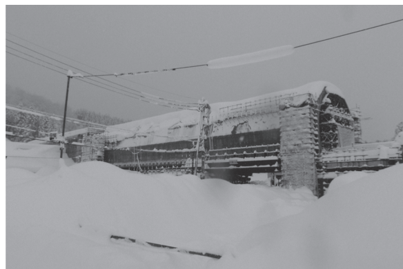
写真 - 3 冬期施工状況
