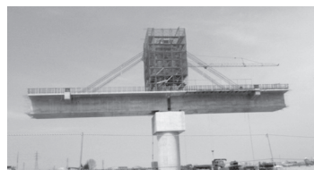
写真 斜吊工法による上部工施工状況
