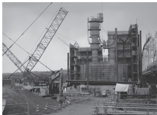
写真 - 1 ニューマチックケーソン施工状況
