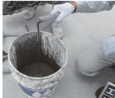
写真 - 2 排出口での PC グラウトの確認状況
