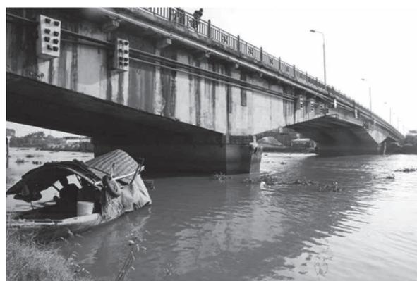
写真 - 10 外ケーブル補強された Niem 橋
