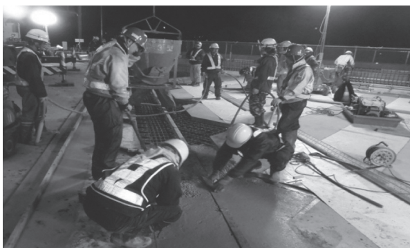
写真 - 9 現場打ちコンクリート打設状況
