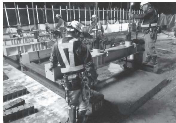
写真 - 6 はく離装置による既設床版の撤去
