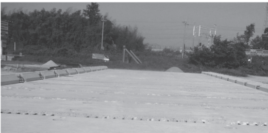
写真 - 4 PCa床版の仮組および一次コンクリートの打設状況
