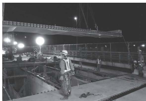
写真 - 7 PCa 床版の架設
