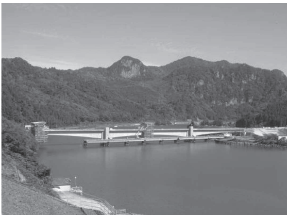
写真 - 1 上部工施工時現場全景
