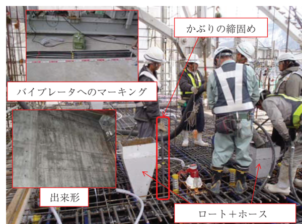
写真 - 4 50-45-20H の打設状況
