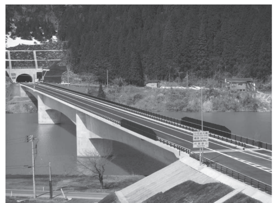
写真 - 7 完成写真
