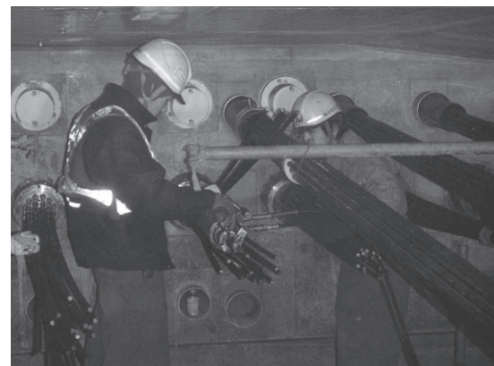
写真 - 6 外ケーブルの緊張状況
