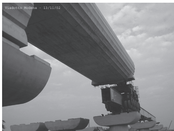
図 - 10 下側架設桁の押し出し
