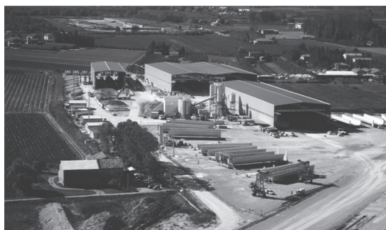
図 - 1 プレキャスト桁製作工場
