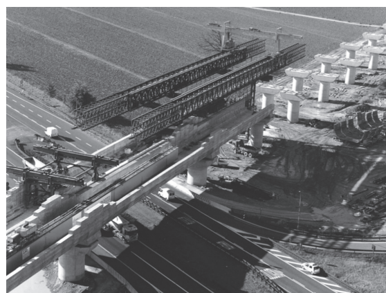
図 - 12 移動架設桁
