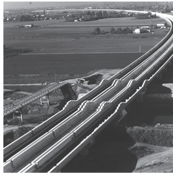
図 - 14 完成後全景
