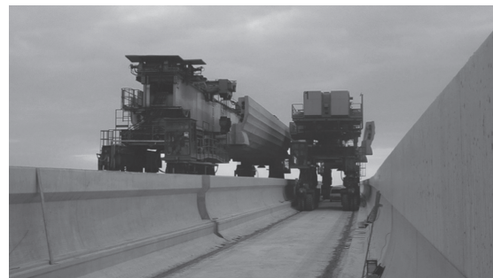
図-8 主桁上での移動
