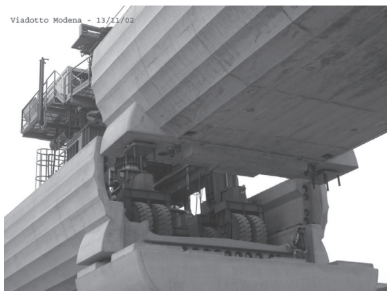
図 - 11 桁の最終設置
