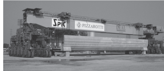
図-7 保管場所からの運搬
