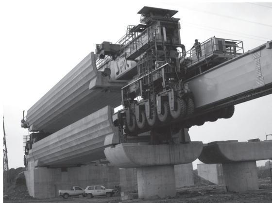
図 - 9 下側架設桁上での移動
