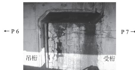
写真 - 3 ゲルバーヒンジ部のひび割れ（2009 年）
