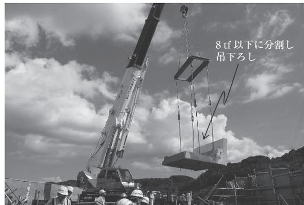
写真 - 6 切断した部材の吊下ろし
