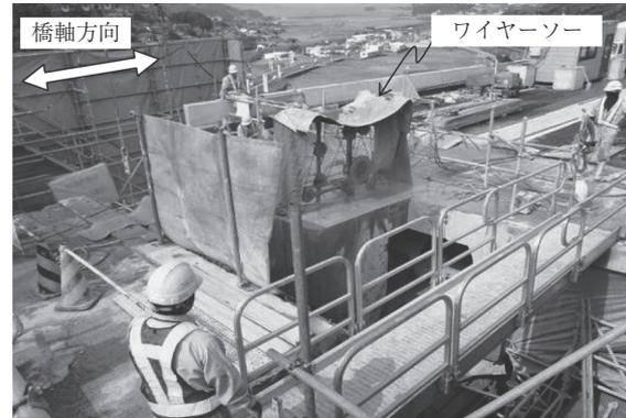
写真 - 5 ワイヤーソーによる切断
