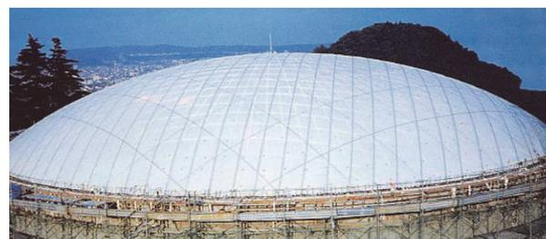
写真-2 空気膜型枠工法(空気膜昇圧時)
