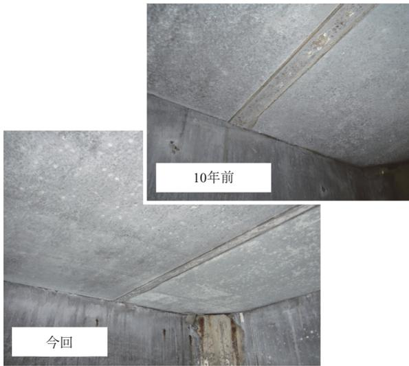
写真 - 3 CFRP 床版下面の状況
