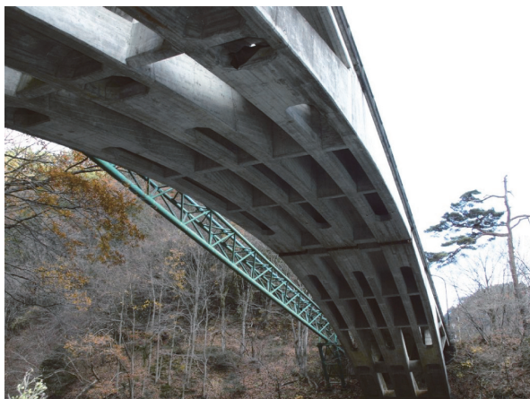
写真 - 1 奥多摩湖に架かる坪沢橋
