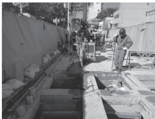
写真 - 4 床版切断状況
