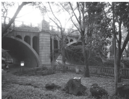
写真 - 3 音無橋の外観
