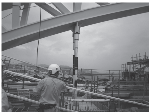
写真 - 6 アーチ鉛直吊材見学状況
