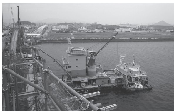
写真 - 7 CP 船 (P2 フィン部コンクリート打設中)
