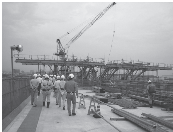
写真 - 4 移動作業車施工部見学状況
