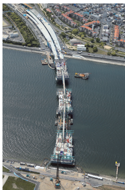
写真 - 1 施工状況全景（西向き）
