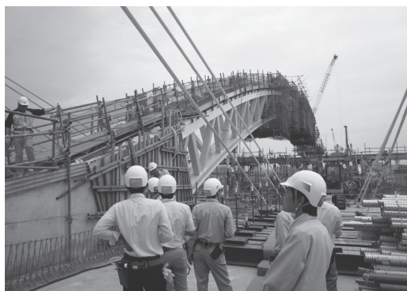
写真 - 5 アーチ接合部見学状況
