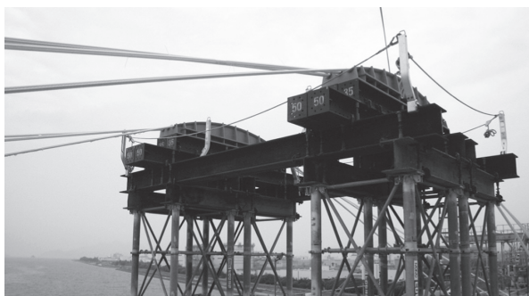
写真 - 3 ピロン支柱と仮斜材サドル部
