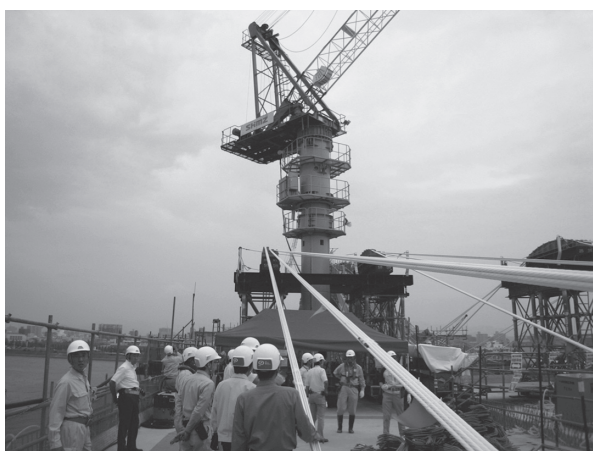
写真 - 2 P3柱頭部見学状況
