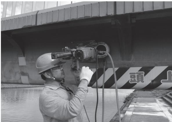
写真 - 3 実橋ウェブからのコア抜きの作業の状況
