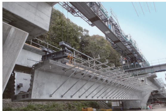
写真 - 1 U 桁リフティング架設
