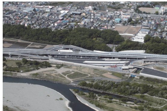
写真 - 2 関口高架橋全景
