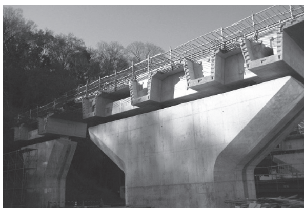
写真 - 5 柱頭部先行施工状況
