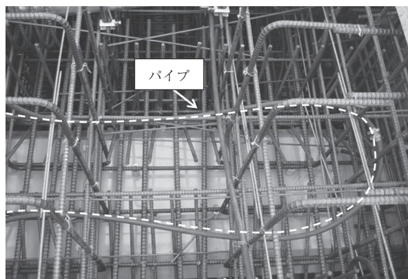
写真 - 4 パイプクーリングの実施状況
