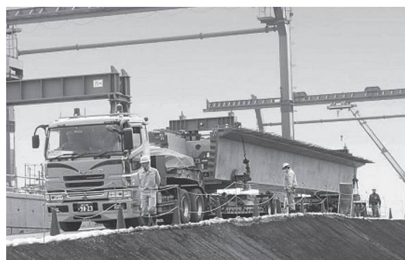
写真 - 7 U桁運搬
