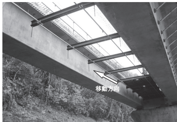
写真-10 吊支保工
