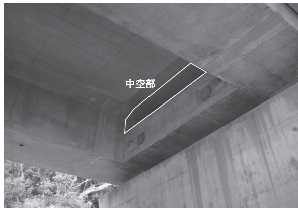
写真-11 支点横桁上の中空部
