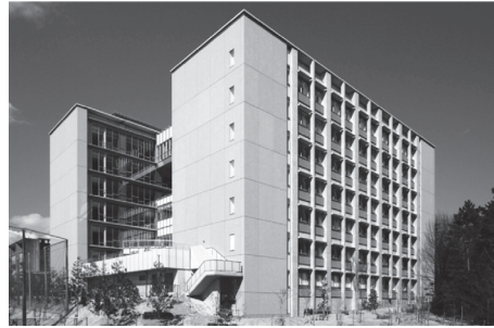
写真 - 17 サッシュを取付けて外装工事完了
