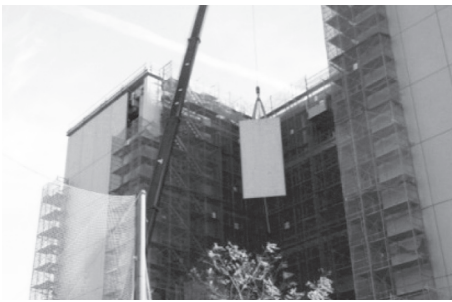
写真 - 16 PCa 妻壁の取付け
