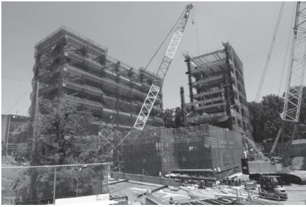
写真 - 10 建方進行中
