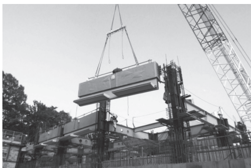
写真 - 7 PCa 大梁と PCa 垂れ壁・小庇の揚重
