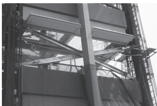
写真 - 6 建方用仮設ブレース
