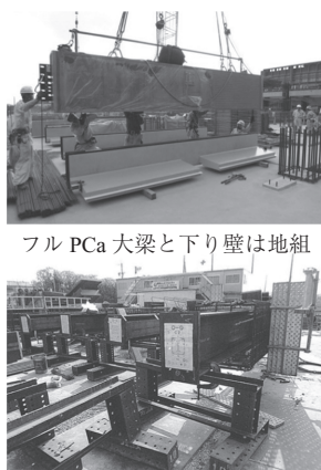
柱鉄骨に柱鉄筋を地組
