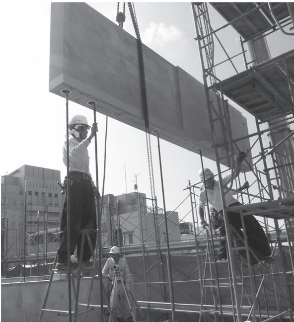
写真-8 PCa壁版の建方
