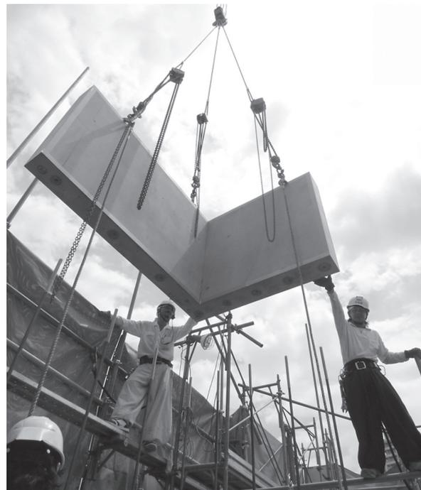
写真-11 L型PCa壁の建方
