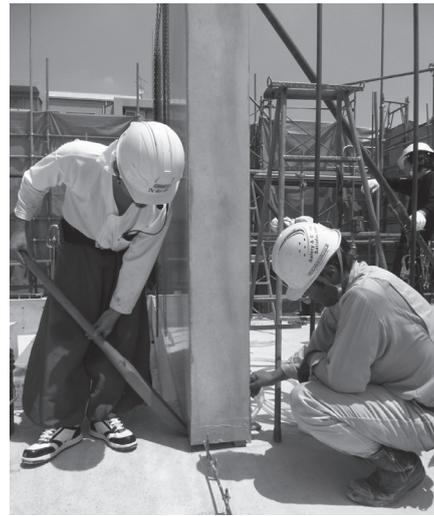
写真-9 木製バールによる微調整
