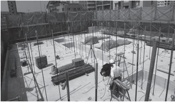
写真-7 PC鋼棒セット風景
