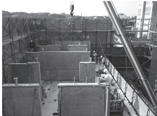
写真 - 13 ひな壇架設
