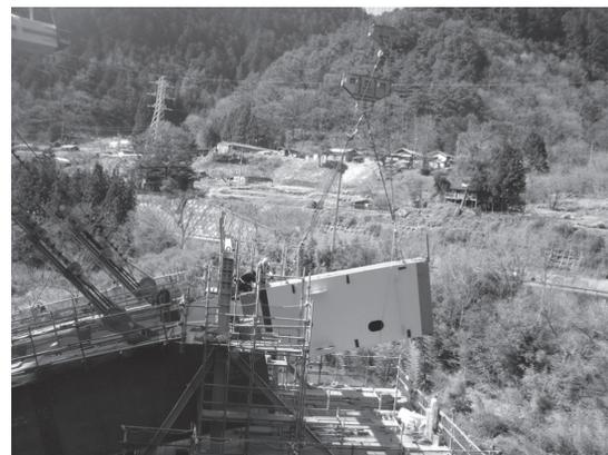
写真 - 4 メラン材架設状況 (左岸)
