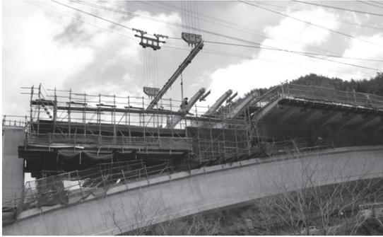
写真 - 13 水平リブ設置状況
