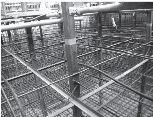
写真 - 11 アーチアバットのパイプクーリング
