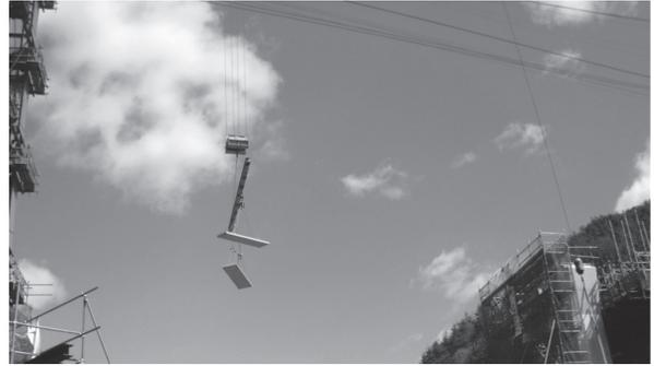
写真 - 15 天秤梁による PC 板運搬
