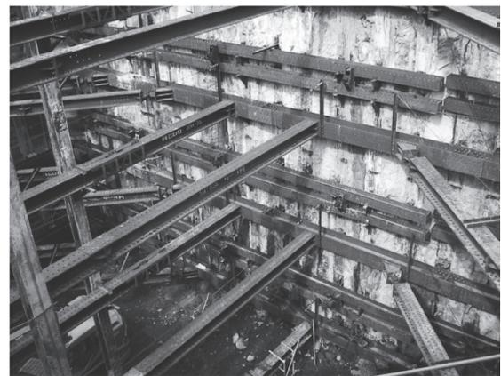
写真-10 AA2 アーチアバット掘削時の変位抑制工
