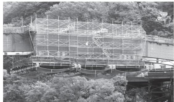
写真-9 クラウン部吊支保工
