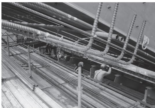
写真-8 アーチリブ下床版鉄筋組立て状況
