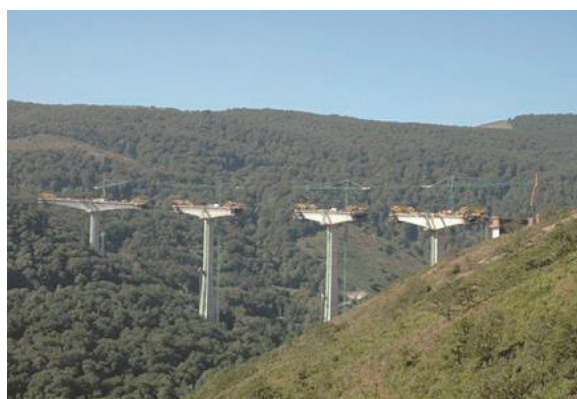
写真 - 6 張出し施工中の全景写真
