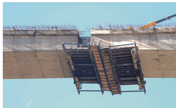
写真 - 8 閉合セグメント施工状況写真
