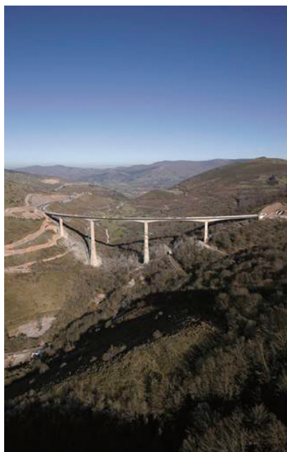
写真 - 1 高架橋全景
