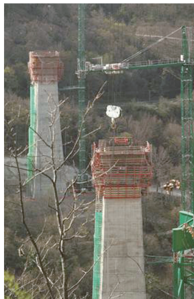
写真 - 4 P2・P3橋脚の施工状況
