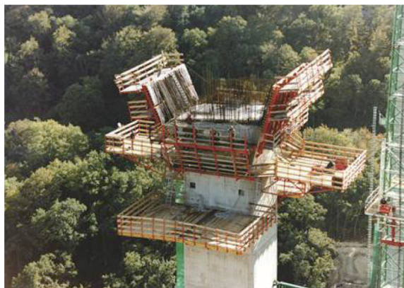
写真 - 5 柱頭部の施工状況写真
