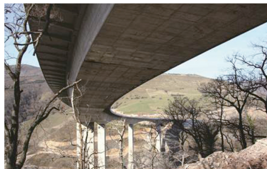
写真 - 2 主桁下面状況（E2 橋台から）
