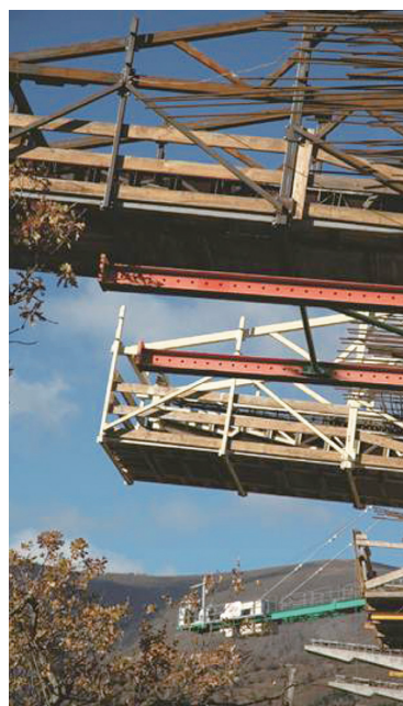
写真 - 7 小型特殊移動作業車による張出し床版の施工状況写真
