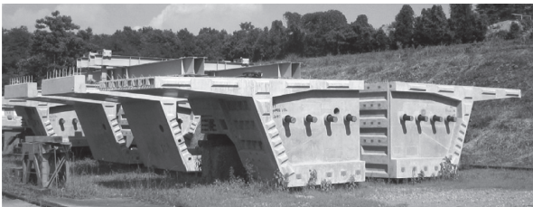
写真 - 1 端部セグメント仮置き状況
