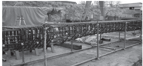
写真 - 5 プレファブ化鉄筋（電柱支持梁）
