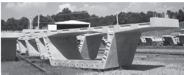
写真 - 2 標準セグメント仮置き状況
