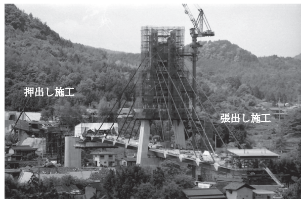
写真-3 張出し施工と押出し施工の状況
