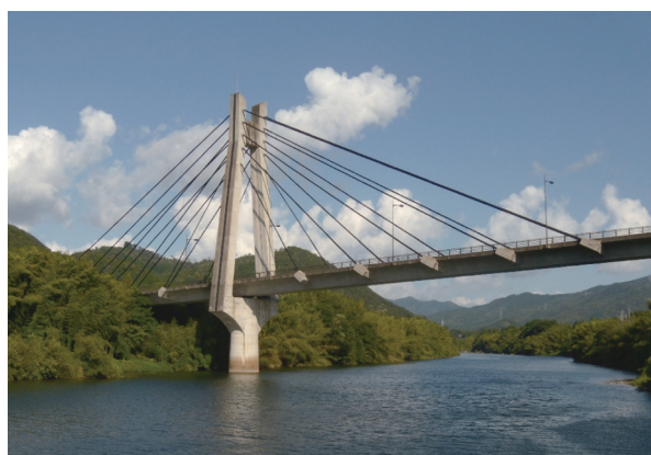
写真 - 1 現在の新綾部大橋
