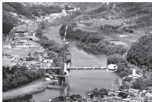
写真 - 2 施工中の新綾部大橋
