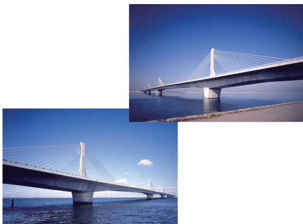
写真 - 2 木曾川橋・揖斐川橋 (トゥインクル)
