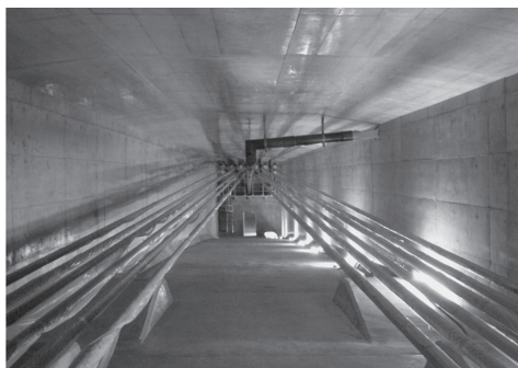
写真 - 7 外ケーブル緊張完了状況
