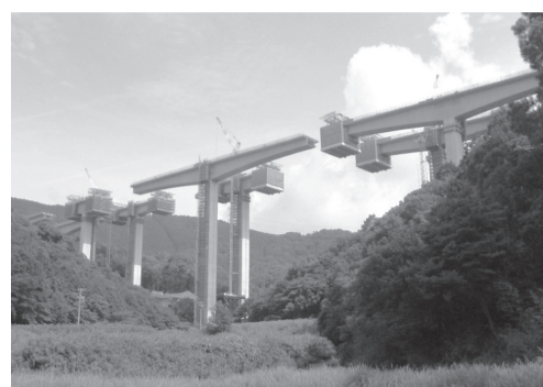
写真 - 4 張出し架設工の施工状況
