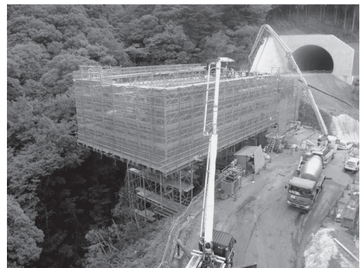
写真 - 6 上り線 A2 側径間 1 リフトの打設状況
