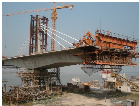
図-8 張出し施工中の移動作業車
