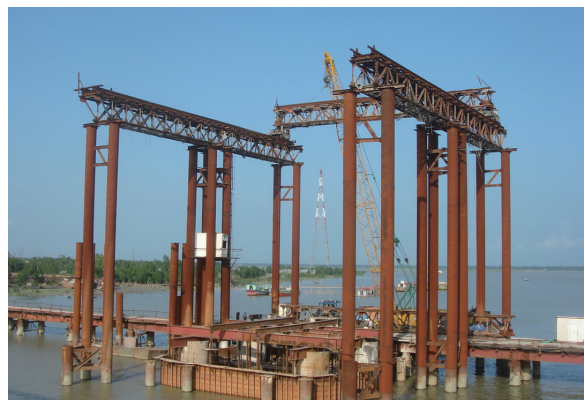
図-7 ガントリークレーンとパイルキャップ施工状況
