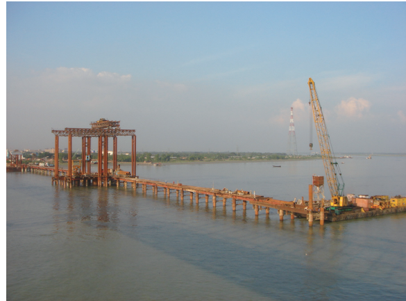
図-6 トレスル橋による杭施工時のアクセス
