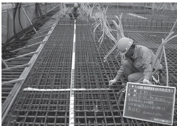
写真 - 1 FRP 格子筋の配置 (定着部付近の床版)
