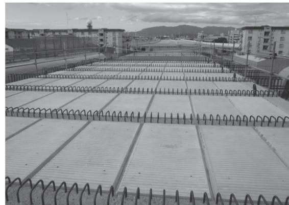
写真 - 4 横リブ・PC板架設完了
