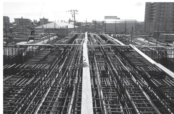
写真 - 5 支点横桁の配筋
