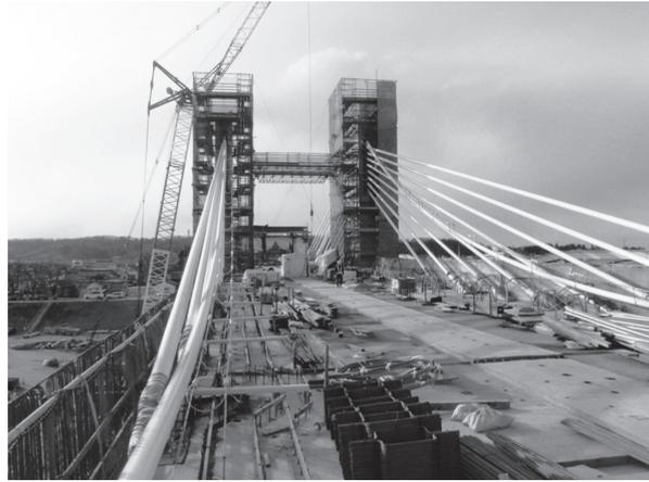
写真 - 6 保護管吊上げ状況
