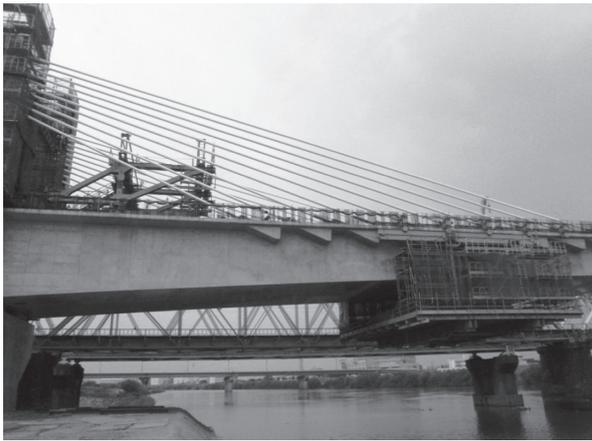
写真 - 4 移動式作業車解体状況
