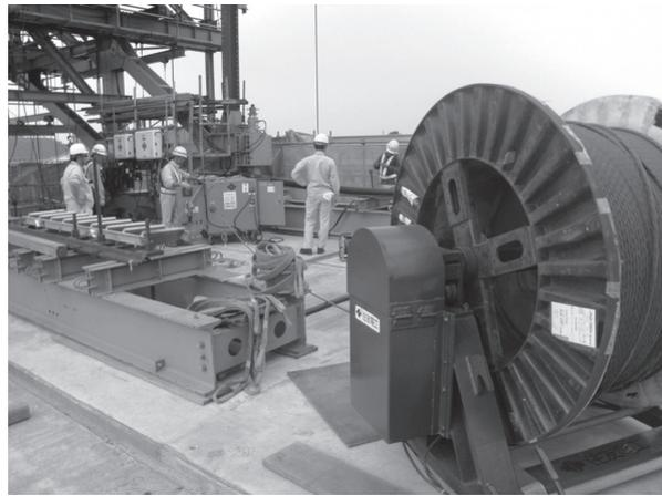
写真 - 7 PC 鋼材挿入状況
