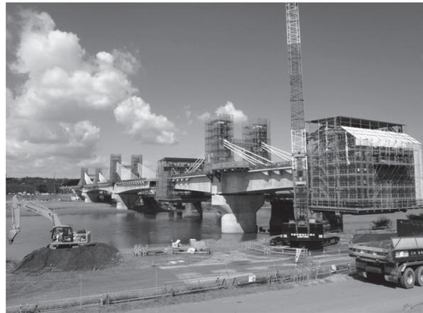
写真-2 張出し施工状況
