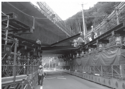
写真 - 2 開口部の支保工解体状況
