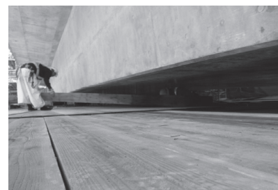
写真 - 5 桁下空間
