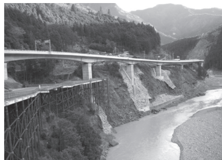
写真 - 12 今戸高架橋完成写真
