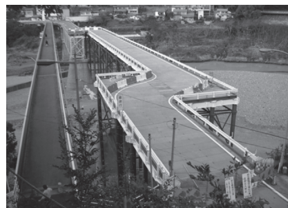
写真 - 14 折立橋応急復旧橋完成写真
