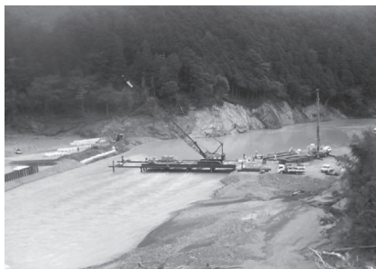
写真 - 9 渡河部における仮橋の設置
