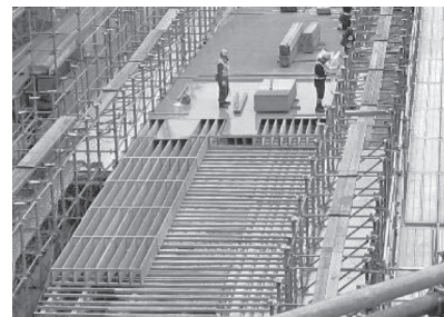
写真 - 4 櫛材の設置状況
