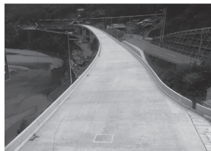
写真 - 13 今戸高架橋完成写真（橋面）
