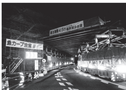
写真 - 3 開口部の視線誘導対策
