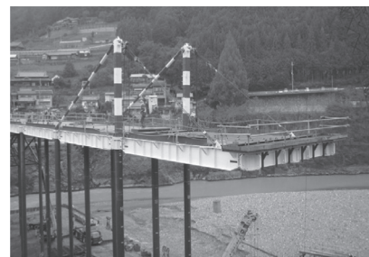
写真 - 11 鋼製パネルの斜張式架設
