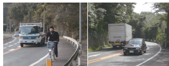
写真 - 1 現道の整備状況
