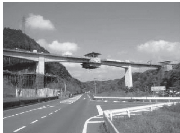
写真 - 2 架設状況
