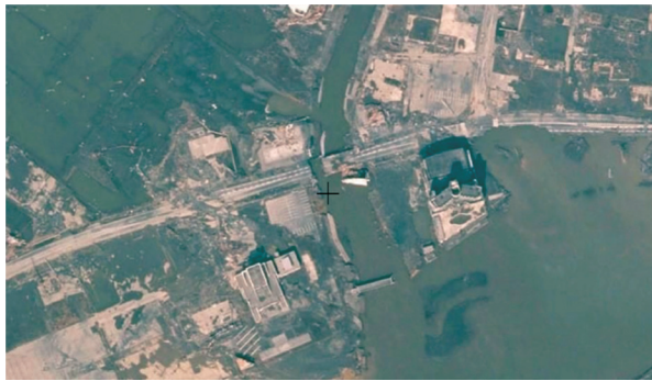
写真 - 3 被災直後の川原川橋（航空写真） 1)
