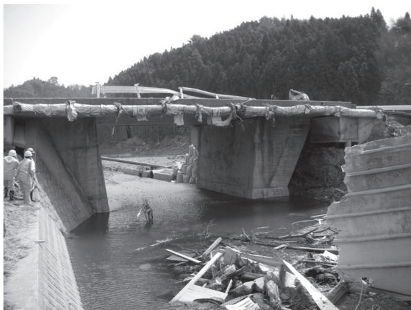
写真 - 17 歌津 2 号橋
