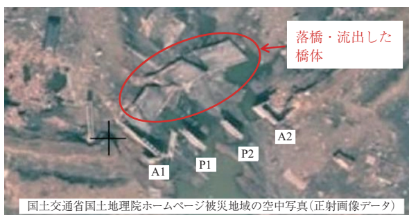
写真 - 5 被災直後の沼田跨線橋（航空写真） 1)
