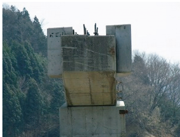
写真 - 7 落橋防止構造（沼田跨線橋）
