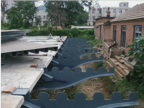
図-9 鋼製片持ち梁設置状況
