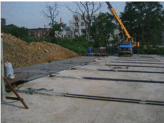
図-10 鋼製床版設置状況
