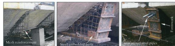
図 - 8 ダイアフラム施工状況
