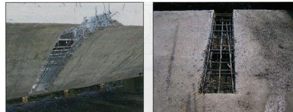
図 - 7 既設箱桁の切欠き状況
