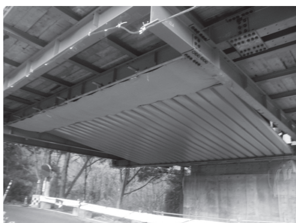
写真 - 6 落下物防止対策
