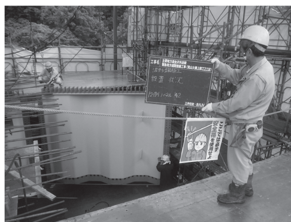
写真 - 7 波形鋼板架設状況 (P1)
