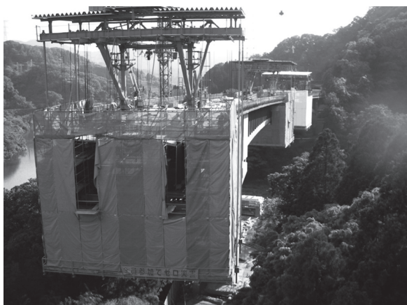
写真 - 8 波形鋼板配置準備状況 (P2)
