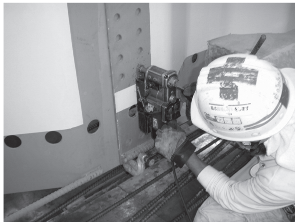
写真 - 1 閉合部ボルト孔削孔状況
