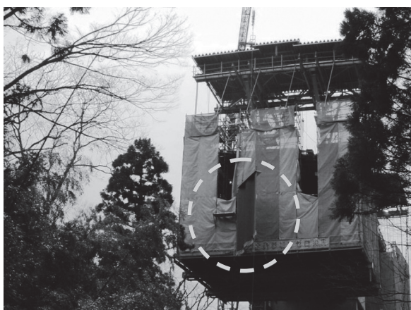
写真 - 9 波形鋼板荷揚げ状況 (P2)
