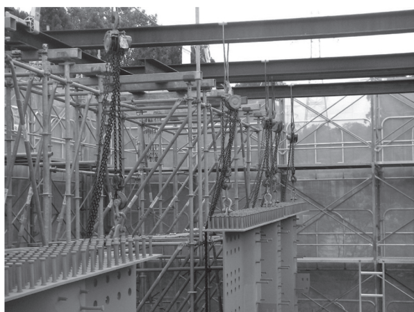
写真 - 3 柱頭部波形鋼板設置状況
