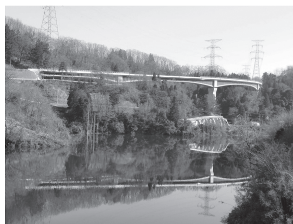
写真 - 12 完成写真
