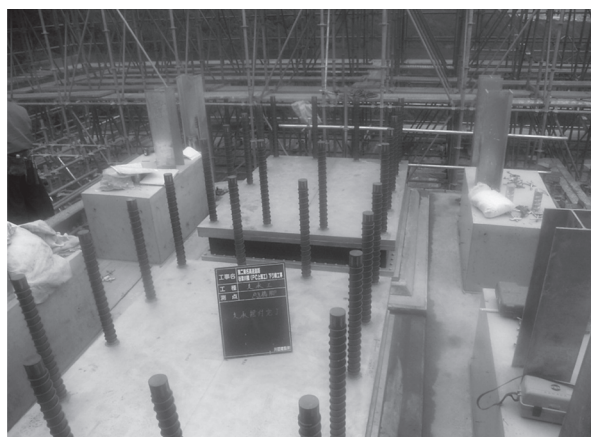
写真 - 4 超高減衰積層ゴム支承の設置状況
