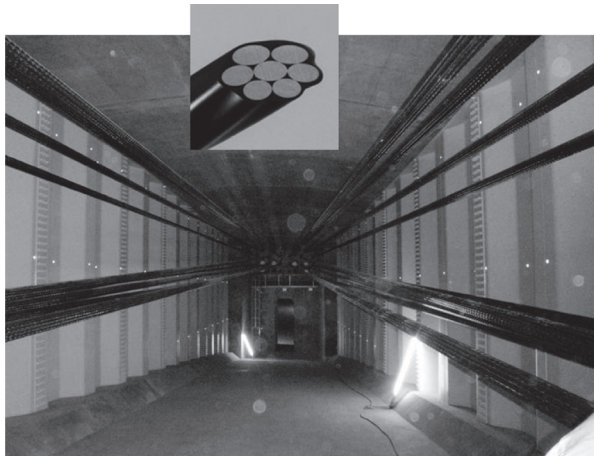
写真 - 11 エポキシ樹脂被覆 PC 鋼材
