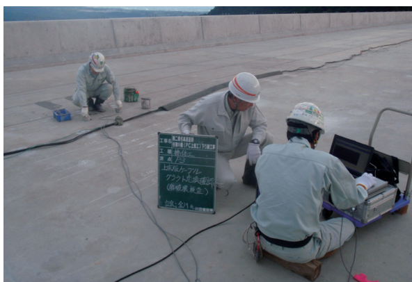
写真 - 16 グラウト充てん非破壊検査状況
