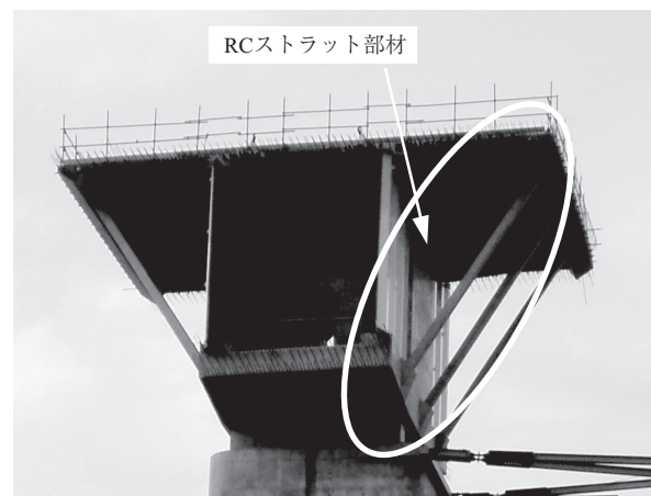
写真 - 8 RC ストラット部材
