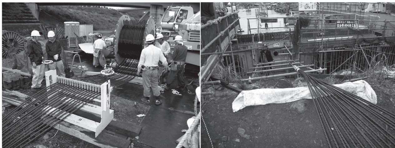
（エポキシ樹脂被覆 PC 鋼材挿入状況）
