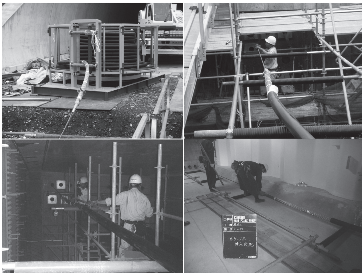
（亜鉛めっきマルチ PC 鋼材挿入状況）
