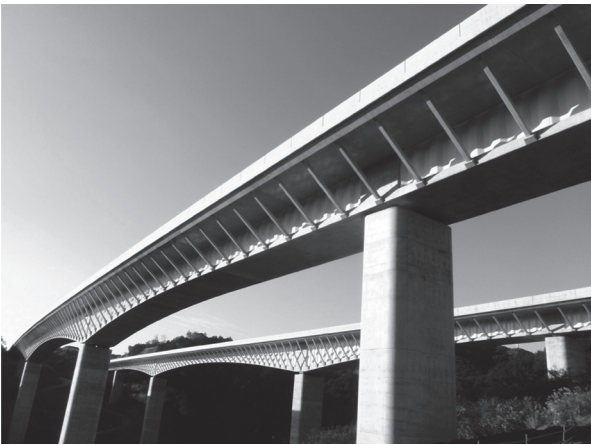
写真 - 20 完成写真
