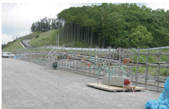
写真 - 15 グラウト注入試験状況
