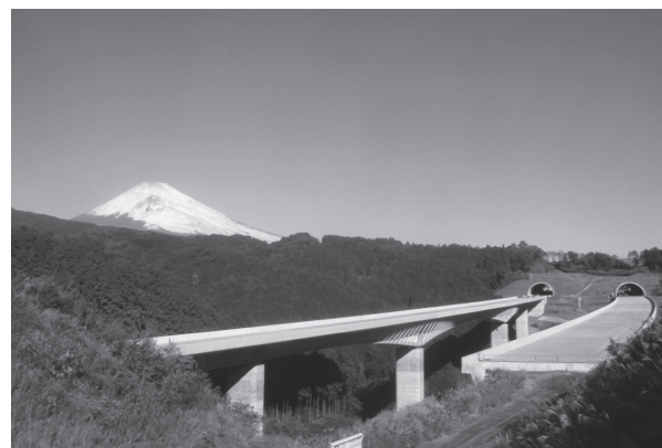
写真 - 2 完成全景（上り線、下り線）
