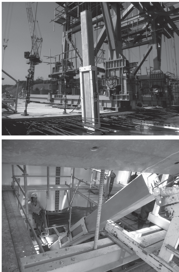
写真 - 19 ストラット架設状況
