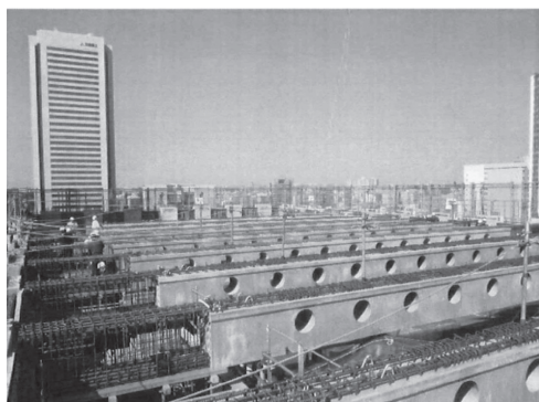
写真 - 5 PCaPC 梁設置状況
